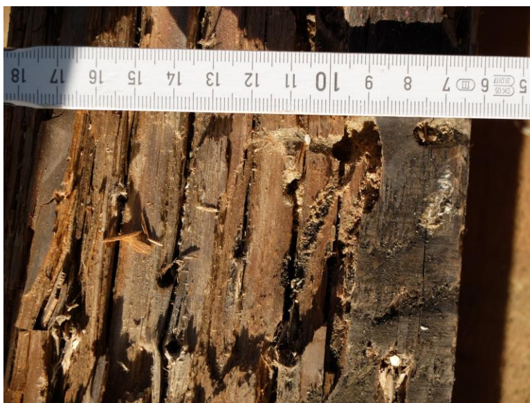
Abbildung 2 Befall eines neuwertigen Deckenbalkens (Flachdachkonstruktion mit Sparrenzwischen-dämmung BJ 2008) durch Frischholz- und Trockenholzinsekten
